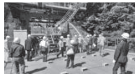
リブレース工事現場を見学
