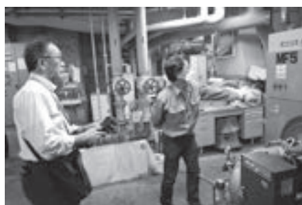
館内設備のチェック
